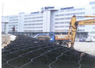
Рисунок 1. Геоячейки «ПРУДОН-494» для объемного армирования грунтов
