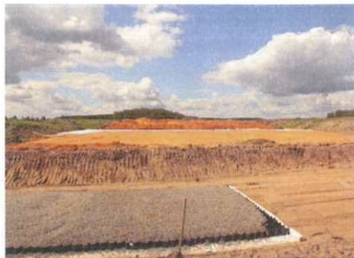
Рисунок 1. Геоячейки «ПРУДОН-494» для объемного армирования грунтов
